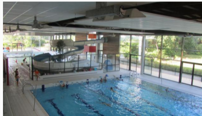
Figure 16: Photo du hall des bassins
